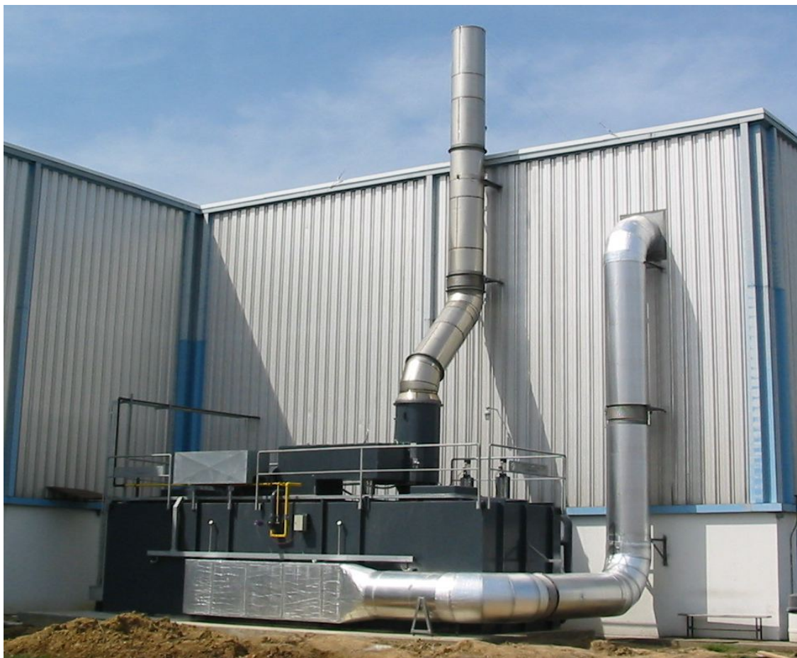
Рис. 3. Регенеративный термический окислитель на заводе «Хемпель» в населенном пункте Бук (Польша)
